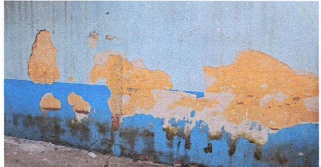
Foto 2: mantenimiento de repello en el exterior de EODP
