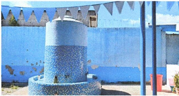
Foto 3: se necesita un deposito para distribuir agua a los sanitrios
