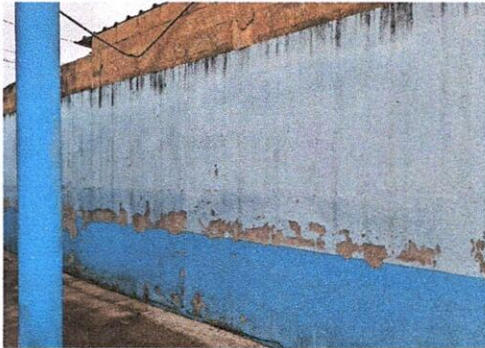
Foto1: mantenimiento de repello interior de la EODP
