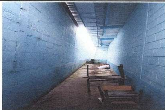
Foto 3: reparación de techo, bajada de agua pluvial y piso de cemento
