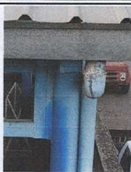
Foto 2: CANALES Y BAJADAS DE AGUA PLUVIAL.
