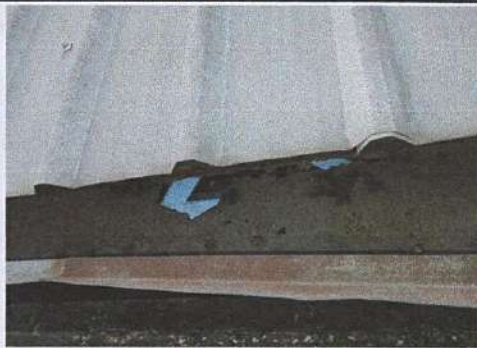
Foto 3: CANALES Y BAJADAS DE AGUA PLUVIAL.
