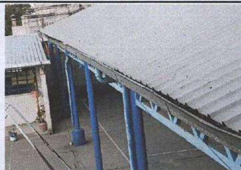
Foto 6: CANALES Y BAJADAS DE AGUA PLUVIAL.
