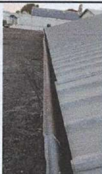
Foto 1: CANALES Y BAJADAS DE AGUA PLUVIAL.
