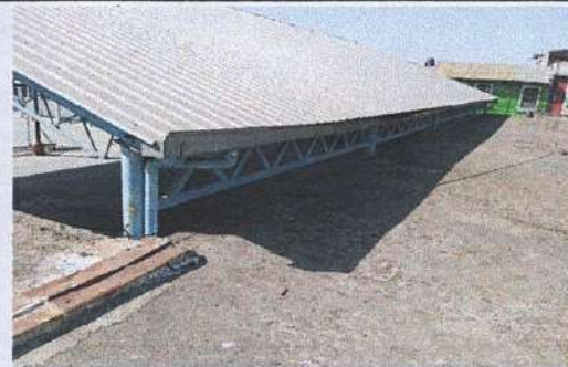
Foto 2: ESTRUCTURA METÁLICA Y CUBIERTA DE LAMINA PARA EVITAR ENTRADA DE LLUVIA
