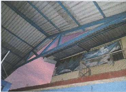
Foto 1: ESTRUCTURA METÁLICA Y CUBIERTA DE LAMINA PARA EVITAR ENTRADA DE LLUVIA
