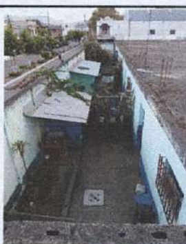
Foto 4: ESTRUCTURA DE TECHO Y CUBIERTA DE LAMINA.
