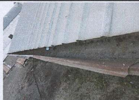
Foto 4: CANALES Y BAJADAS DE AGUA PLUVIAL.
