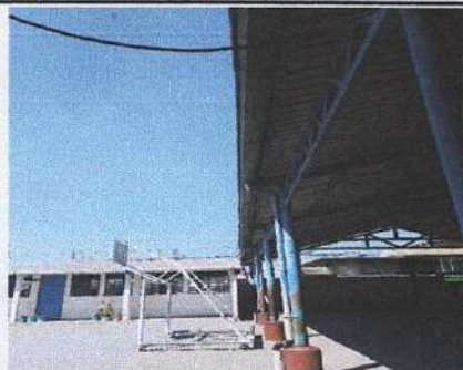
Foto 5: CANALES Y BAJADAS DE AGUA PLUVIAL.
