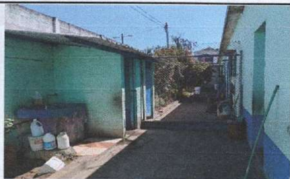
Foto 3: ESTRUCTURA DE TECHO Y CUBIERTA DE LAMINA.
