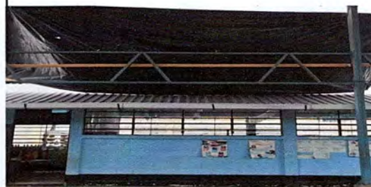
FOTO 16. REMOZAMIENTO DE CUBIERTA DE LÁMINA EN LA PARTE SUPERIOR
