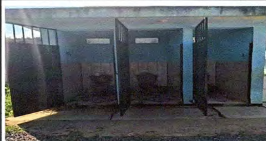
FOTO 7. REMOZAMIENTO DE ACCESORIOS DE SANITARIOS
