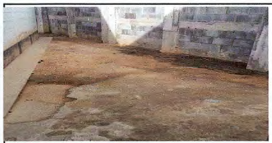
FOTO 12. REMOZAMIENTO DE TORTA
