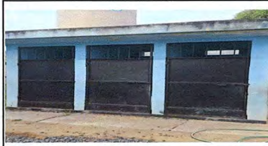
FOTO 14. REMOZAMIENTO DE PINTURAS DE PUERTAS SANITARIOS
