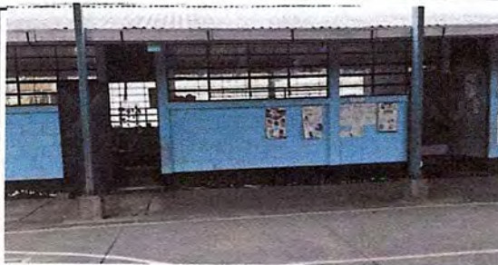
FOTO 3. REMOZAMIENTO DE PINTURA DENTRO Y FUERA DE AULAS
