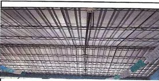
FOTO 5. REMOZAMIENTO DE CAMBIO DE FOCOS
