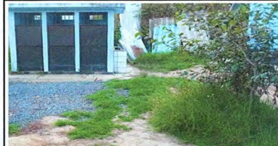
FOTO 10. REMOZAMIENTO DE TORTA DE SANITARIOS
