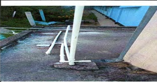
FOTO 9. REMOZAMIENTO DE ACCESORIOS DEL DEPOSITO
