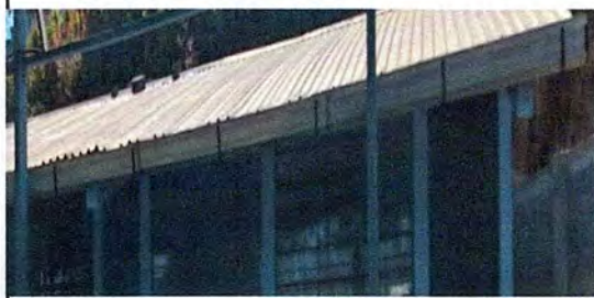
FOTO 15. REMOZAMIENTO DE CANALES
