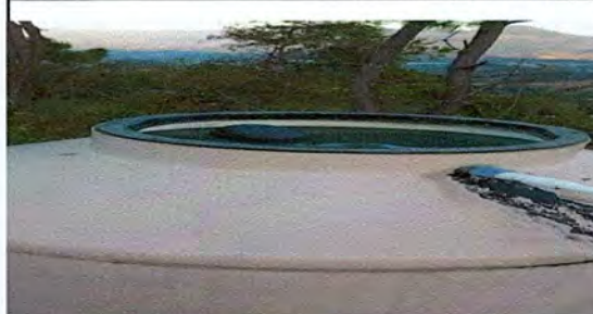
FOTO 8. REMOZAMIENTO DEL DEPOSITO DE AGUA
