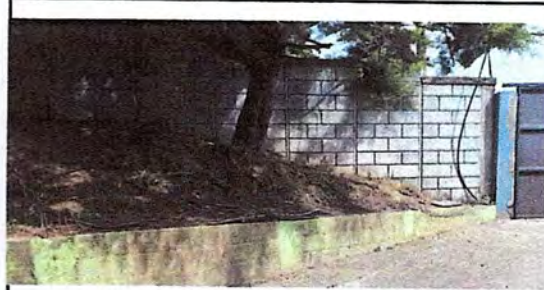
FOTO 4. REMOZAMIENTO DE CABLEADO DE ENERGIA ELECTRICA
