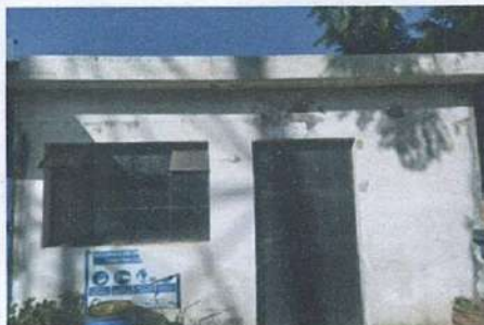
Foto 6: MODIFICACIÓN DE VENTANA
