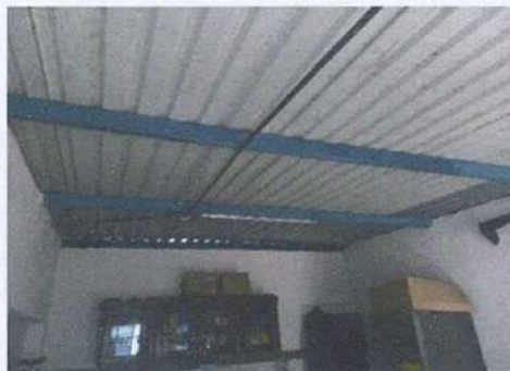
Foto 2: MANTENIMIENTO DE LUZ ELECTRICA
