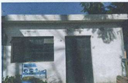
Foto 5: MANTENIMIENTO DE PUERTA Y CANALETAS
