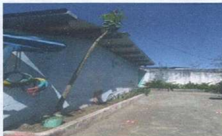
Foto 5: INSTALACION DE PUERTAS Y VENTANAS
