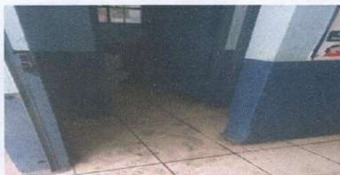
Foto 5: CAMBIO DE PISO
