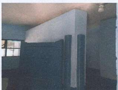
Foto 3: MANTENIMIENTO DE PUERTAS Y ELABORACION DE PUERTAS
