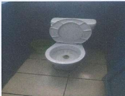
Foto 4: MANTENIMIENTO DE BAÑOS Y CAMBIO DE BAÑOS
