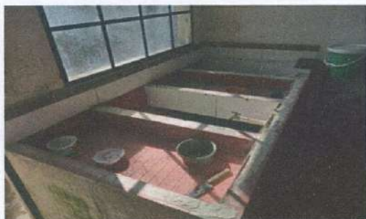
MANTENIMIENTO DE PILA
