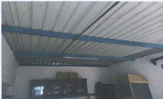
Foto1: CAMBIO DE TECHADO DE COCINA
