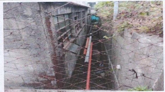
Foto 4: AMPLIACION DE MALLA PERIMETRAL ATRÁS
