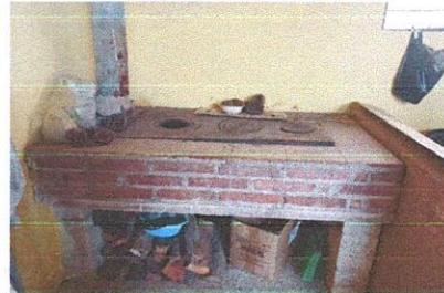
FOTO 4. SUSTITUCIÓN DE ESTUFA RURAL COMPLETA INCLUYE CHIMENEA Y PLANCHA DE METAL
