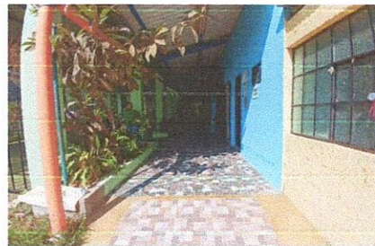
FOTO 6. ELABORACIÓN E INSTALACIÓN DE PORTÓN DE REJAS
