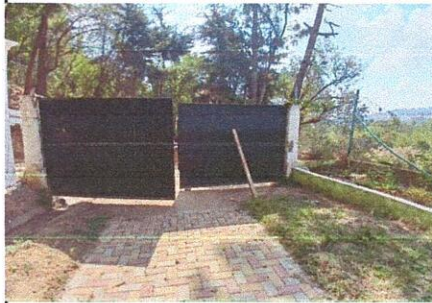
FOTO 2. MANTENIMIENTO A PORTONES DE METAL (VIGA)
