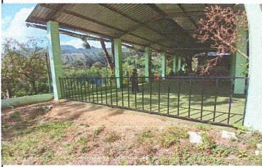
FOTO 1. MANTENIMIENTO A BARANDAS DE METAL
