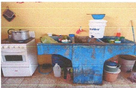
FOTO 5. SUSTITUCIÓN DE PILA DE CEMENTO DE DOS LAVADEROS
