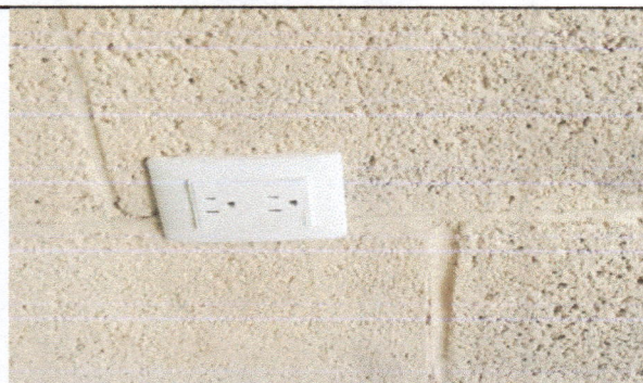
Foto 4: colocación de tomacorrientes (nuevos).
