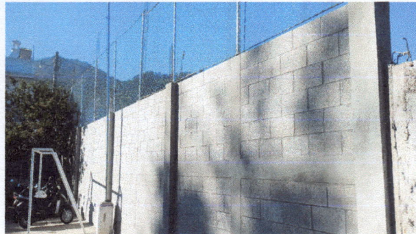
Foto 2: colocación de tubos y mallas. (muro perimetral)
