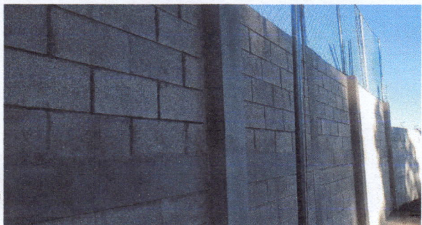
Foto1: terminación de la pared (muro perimetral)
