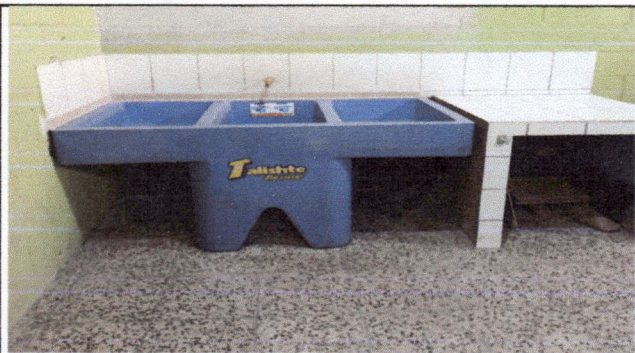
Foto 3: Sustitución de pila.
