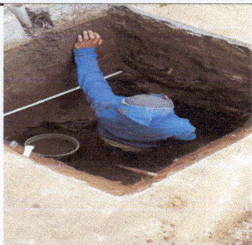
Foto1: Pared, realización de los simientos (muro perimetral)
