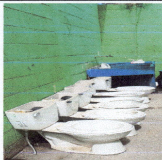
Foto 6: Instalación de sanitarios.
