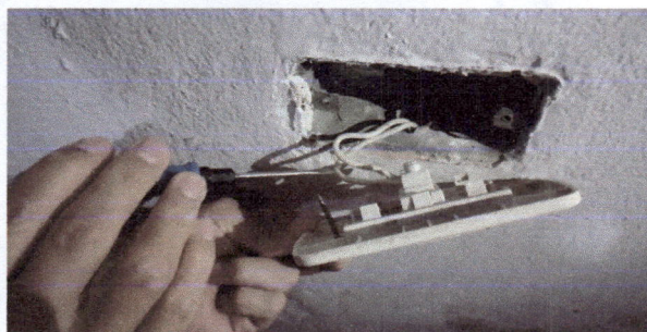
Foto 4: colocación de tomacorrientes (nuevos).
