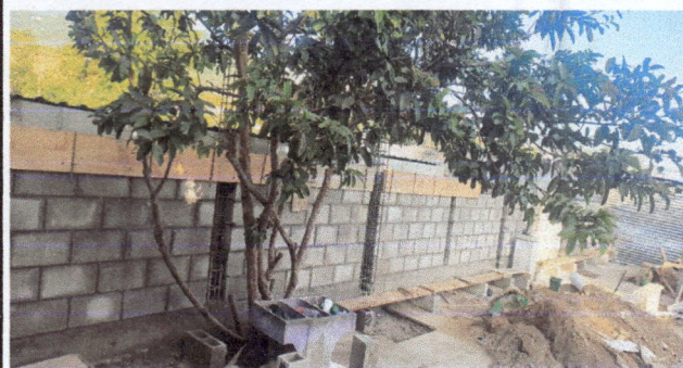
Foto 2: levantado de pared (muro perimetral)
