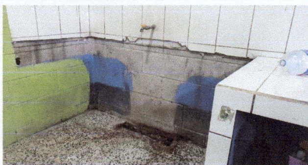
Foto 3: Sustitución de pila(revisión de drenaje).
