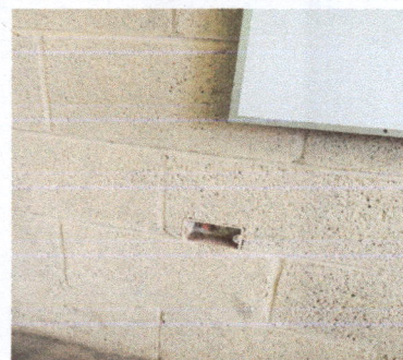
Foto 4: Colocación de toma corrientes.
