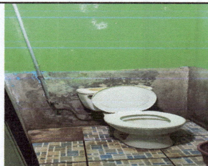
Foto 6: Instalación de sanitarios.
