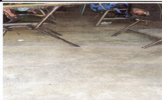
Foto 5: Cambio de piso de concreto por piso cerámica.
