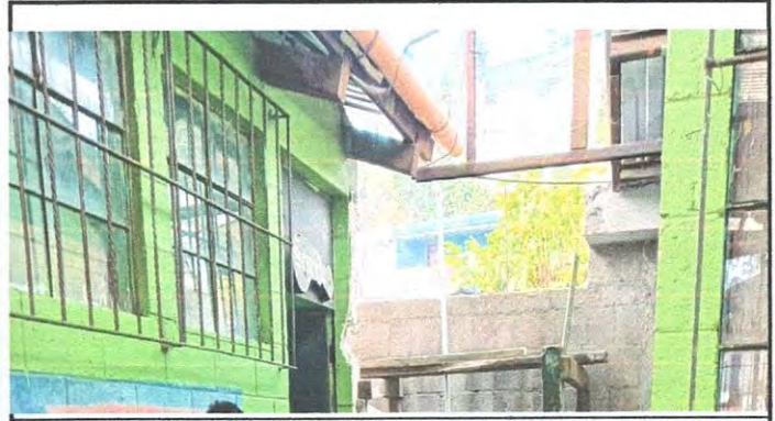
Foto 2: LEVANTADO DE ALTURA DE MURO PERIMETRAL EXISTENTE POR SEGURIDAD
