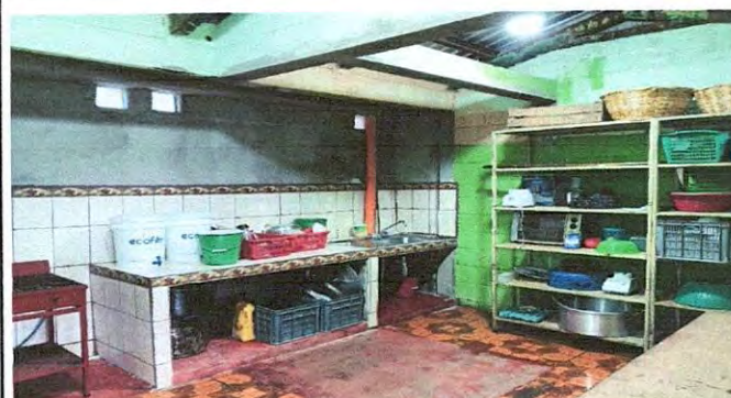
Foto 3: Implementación de un gabinete aereo y un gabinete fundido y colocacion de puertas de metal
