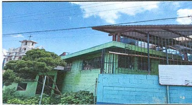
Foto 2: Seguimiento al muro perimetral por seguridad
