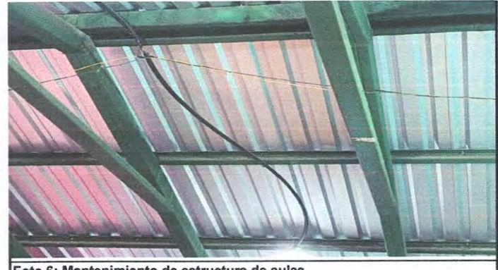
Foto 6: Mantenimiento de estructura de aulas
