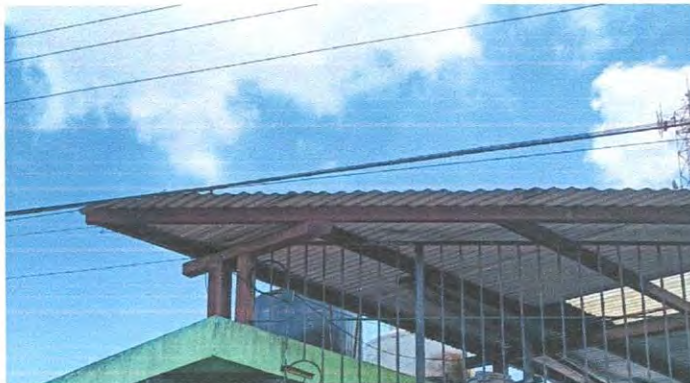
Foto 3: Cambio de depositos de agua
