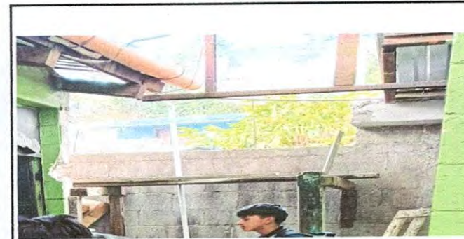
Foto 6: Sustitución de cableado eléctrico
