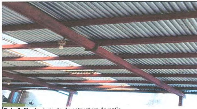
Foto 5: Mantenimiento de estructura de patio
