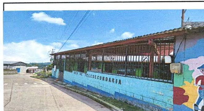
Foto 4: Mantenimiento a Baranda de muro perimetral
