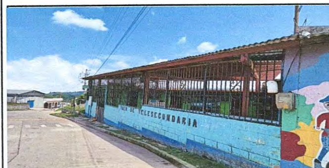
Foto 5: Mantenimiento a estructura de techo de patio Frontal
