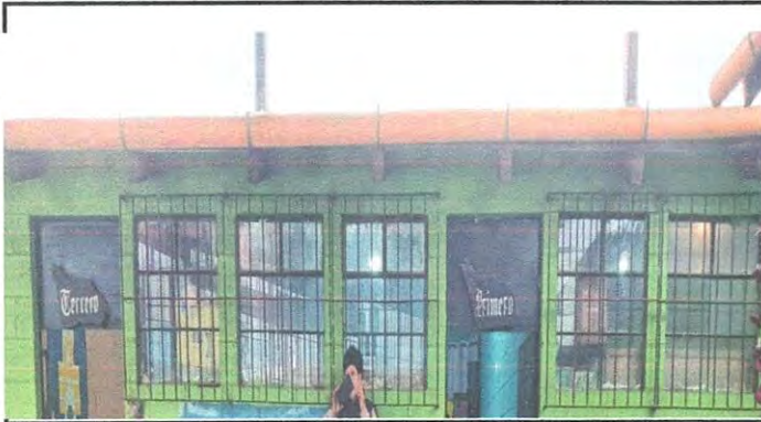
Foto 1: MANTENIMIENTO A BALCONES Y VENTANAS
