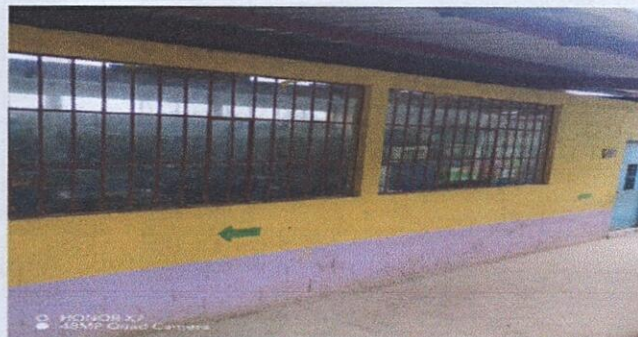
Foto 2: pintura de exterior de 2 salones de clases del módulo 2
