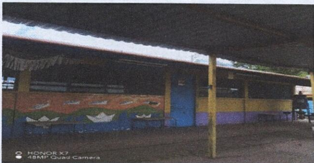
Foto 1: pintura de exterior de dirección, bodega y 2 salones de clases del módulo 1
