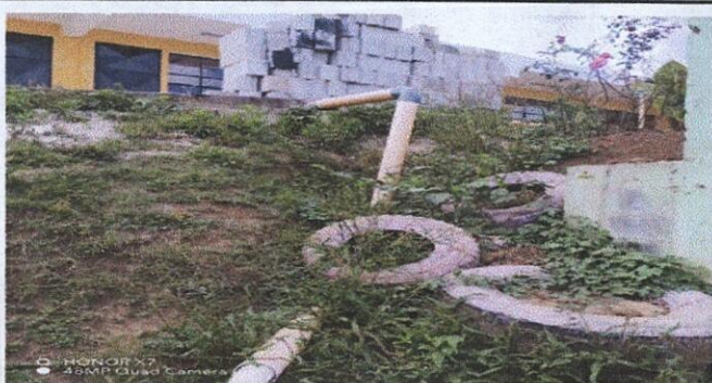
Foto 3: Protección de talud en riesgo con muro de contención en el área de jardín
