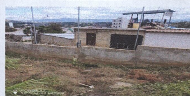
Foto 6: Con la protección de talud en riesgo con muro de contención se evitará que el muro perimetral en un futuro se derrumbe
