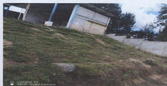
Foto 4: Protección de talud en riesgo con muro de contención para evitar derrumbes por las lluvias
