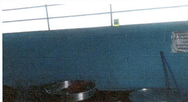
Foto 2: MEJORAMIENTO DE COCINA LADO NORTE
