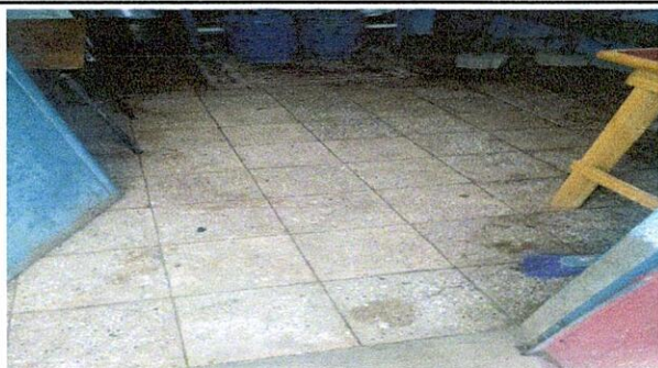
Foto 3: MEJORAMIENTO DE COCINA INTERIOR COCINA, PISO
