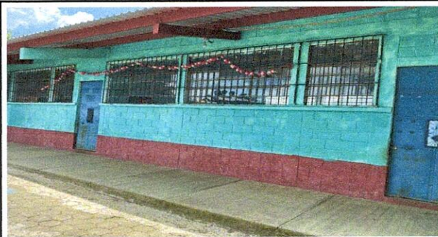
FOTO 4: PINTADO DE EDIFICIO
