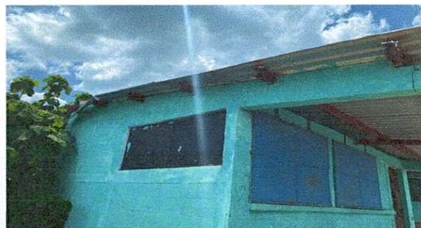
Foto 2: CAMBIO DE VENTANA
