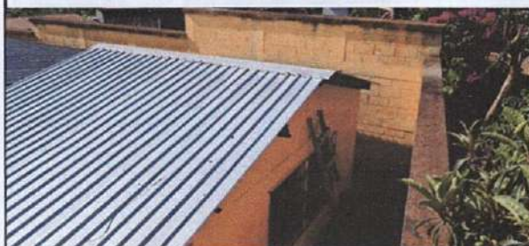
Foto 9: AMPLIACIÓN E INSTALACIÓN DEL NUEVO TECHADO
