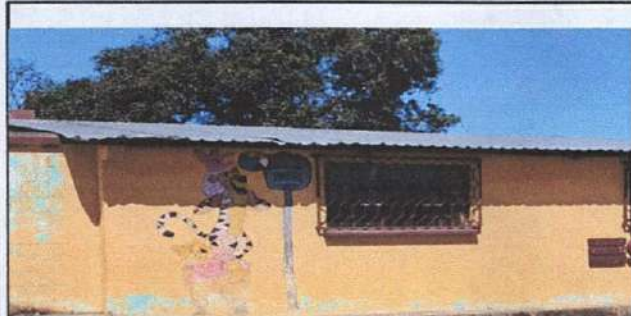
Foto 11: CAMBIO DE LAMINAS EN MAL ESTADO
