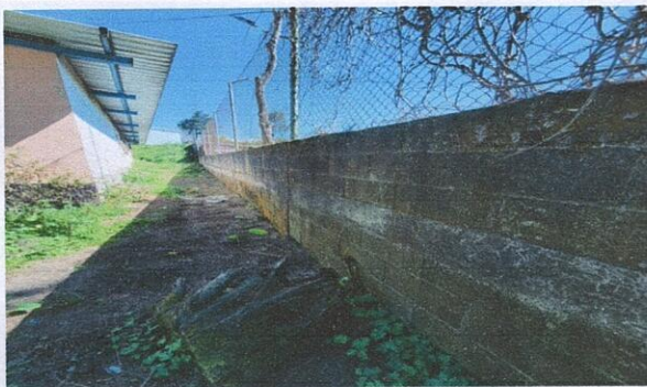
Foto 3: COSTADO LADO IZQUIERDO DEL MURO PERIMETRAL, DE ESTE LADO SE DARÁ SEGUIMIENTO AL MURO EN LA PARTE SUPERIOR, TIENE DE LARGO 27 METROS POR 2 METROS DE ALTO HACIENDO UN TOTAL DE 54 METROS CUADRADOS DE CONSTRUCCIÓN, YA QUE COLINDA CON UNA CASA Y NO ESTÁ SEGURA LA ESCUELA.
