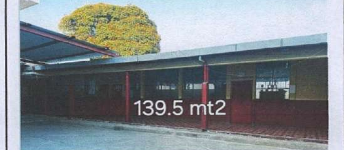
Foto 6: AULAS DEL CORREDOR MODULO 2
