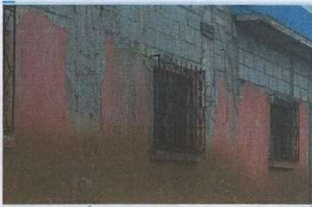
Foto 3: repello y alisado de pared parte trasera Escuela
