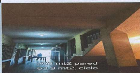
Foto 3: CORREDOR MODULO 1 ENTRADA
