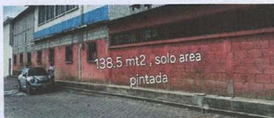
Foto 5: PARTE TRASERA DEL EDIFICIO LADO DE LA CALLE
