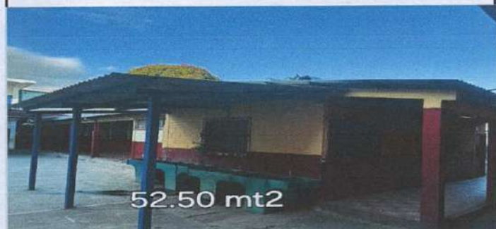
Foto 4: FRENTA A PILAS MODULO 2
