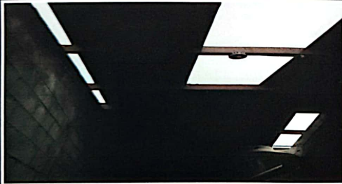
Foto 3: Baños de señoritas sin láminas y deteriorados.
