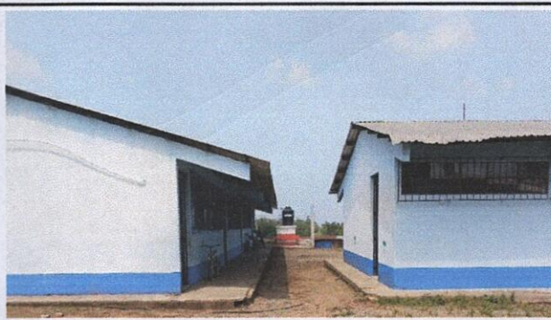
Foto 4: bajadas de agua
