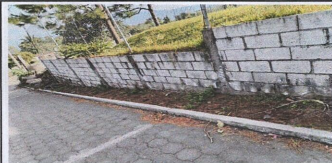
Foto 5 Refuerzo de la pared
