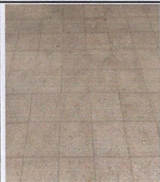
Foto1: cambio de piso en las aulas
