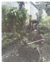
Foto 7: implementación de drenaje terminado
