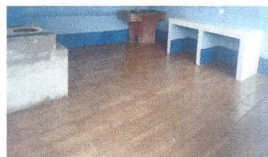
Foto 2: Sustitución de piso de cemento por cerámico terminado
