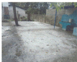
Foto 11: sustitución piso de tierra por concreto terminado
