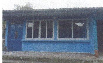
Foto 6: colocación de puerta terminado
