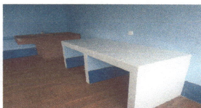
Foto 9: mesa de concreto y azulejo terminado
