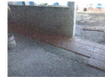
Foto 2: inicio de contra piso de concreto y piso ceramico
