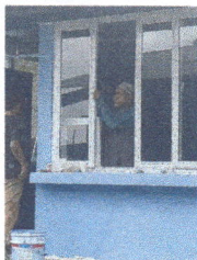
Foto 5: colocación de ventanas
