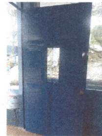
Foto: colocación de puerta de metal con chapa yale
