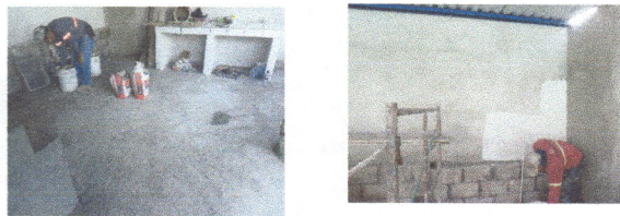
Foto 9: inicio de cernido de paredes
