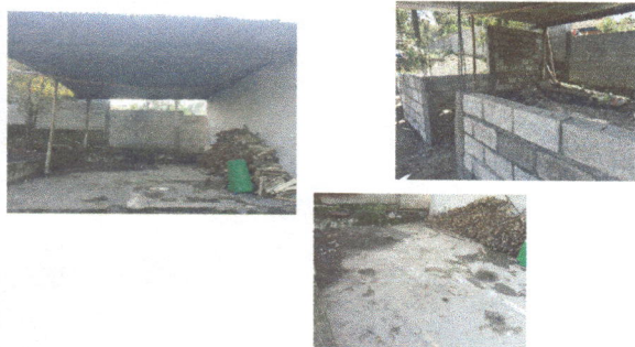
Foto1: continuación de paredes para cocina y techo con estructura metálica, polleton y mesa de concreto, y ventanas, puerta de metal
