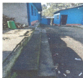
Foto 2: Introducción de drenaje ya que no se cuenta con el mismo
