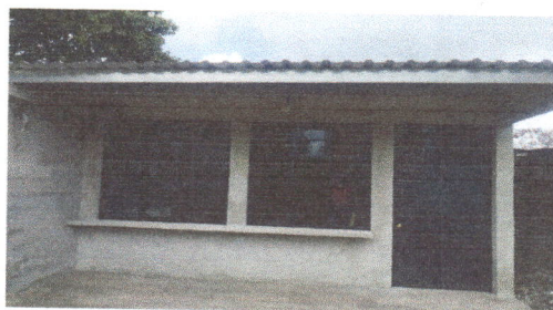
Foto 6: Finalización de cocina.
