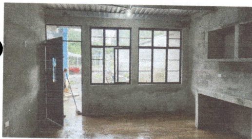
Foto 5: interior de cocina.
