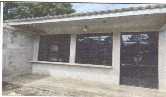
Foto 4: colocación de ventanas y puerta.
