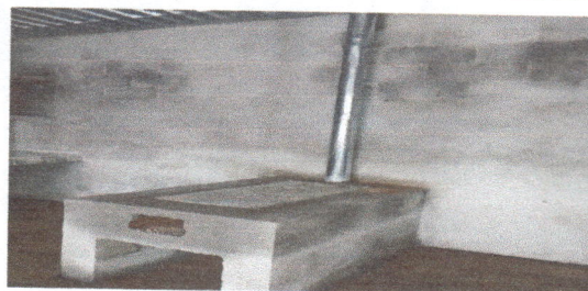
Foto 2: construcción de polletón
