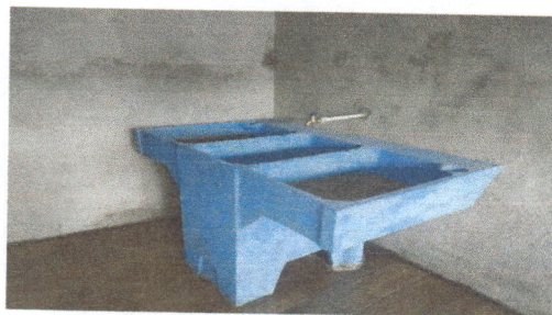
Foto 1: colocación de pila
