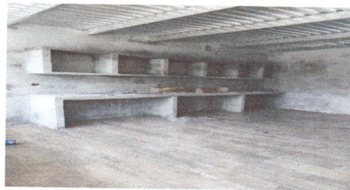
Foto 4: colocación de pisos.
