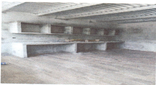
Foto 5: levantado de encimeras y gabinetes.
