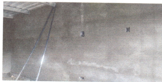
Foto 6: colocación de cables de luz.
