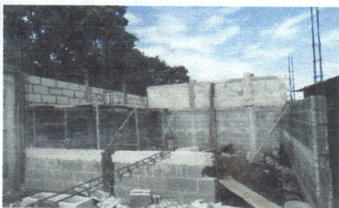
Foto 5: levantado de paredes.
