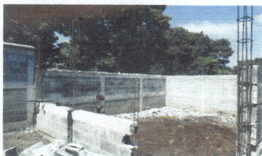
Foto 3: demolición de cemas.
