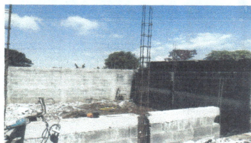
Foto 4: demolición de cemas.
