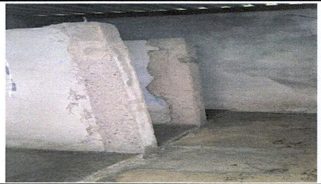
Lugar: donde iría el azulejo en paredes
