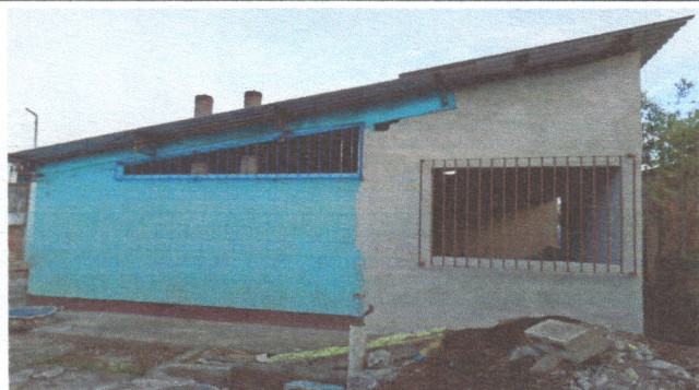
Foto 1: Situación actual de la cocina.
