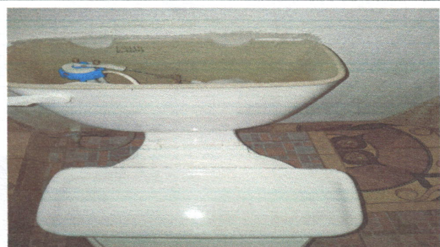
Foto 3: Situación actual de los sanitarios.
