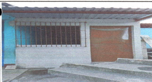
Foto 5: Situación actual de la bodega de cocina.
