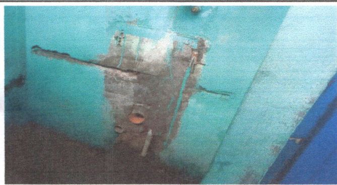
Foto 3: Construcción de mingitorios en los sanitarios.
