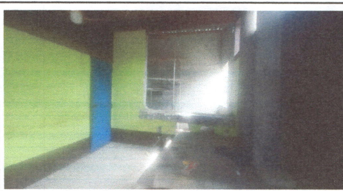
Foto 2: Interior de cocina en remodelación
