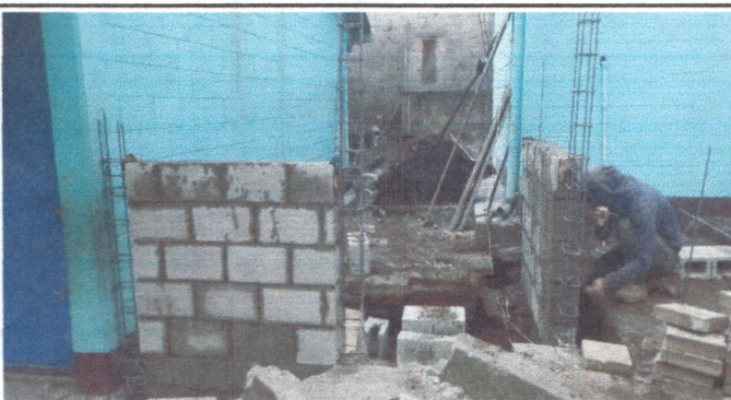
Foto 5: Reparación actual del espacio para bodega de cocina.
