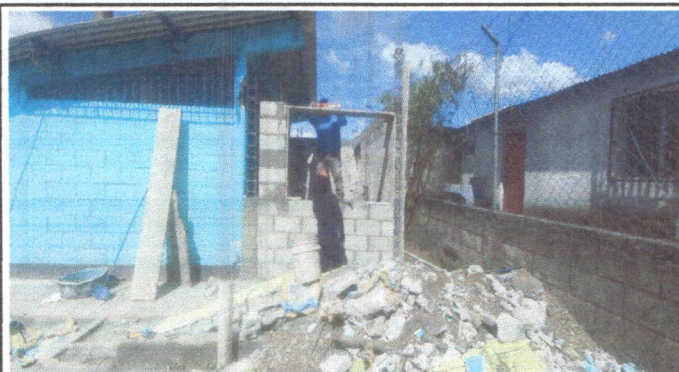
Foto 1: Ampliación de la cocina.
