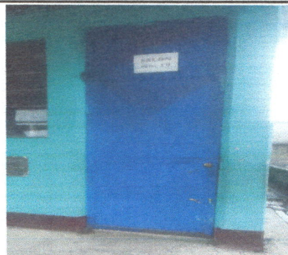
Foto 4: Instalación de chapa.
