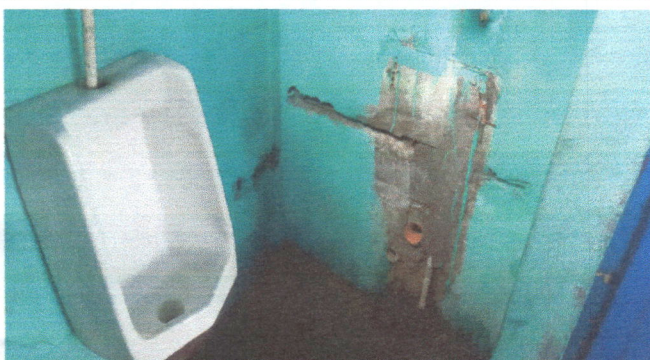
Foto 3: Situación actual de los sanitarios.
