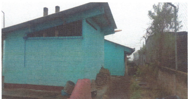
Foto 1: Situación actual de la cocina.
