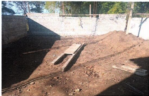
Vista del lugar para la colocación de piso de concreto
