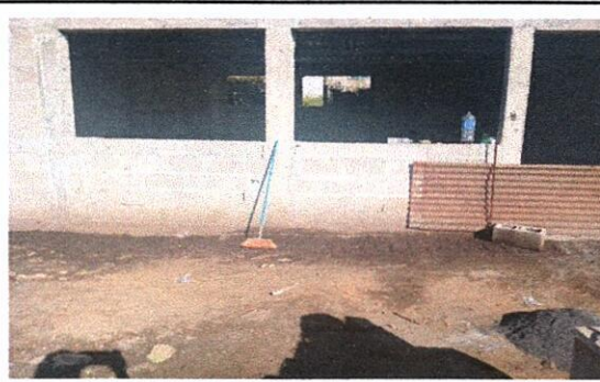
Colocación de Ventanas
