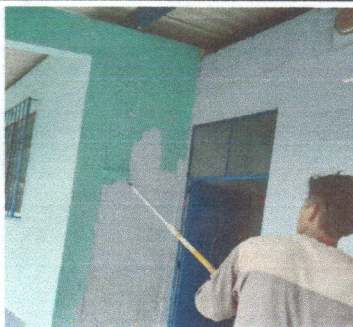
Foto 5: Pintando el corredor y aulas
