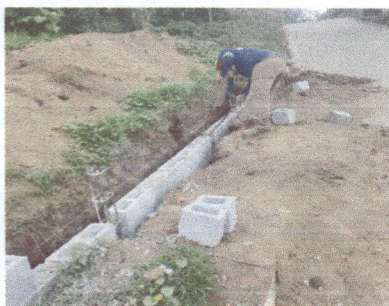
Foto 1: levantado de muro
