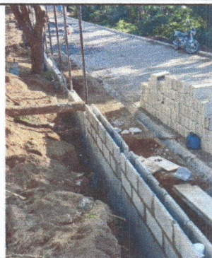
Foto 2: fundicion de columnas
