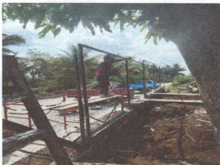
Foto 3: Colocacion de tuvos para la malla de circulacion
