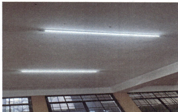
Foto 14: en la imagen se observa el área con las lámparas ya reemplazadas y correctamente instaladas. Todas se encuentran en funcionamiento, proporcionando una iluminación adecuada
