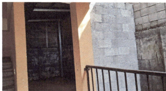
Foto 16: la reparación del portón tras finalizar la reparación, en la imagen se muestra el proton reparado evidenciando un trabajo concluido de manera satisfactoria y dejando el portón en buenas condiciones
