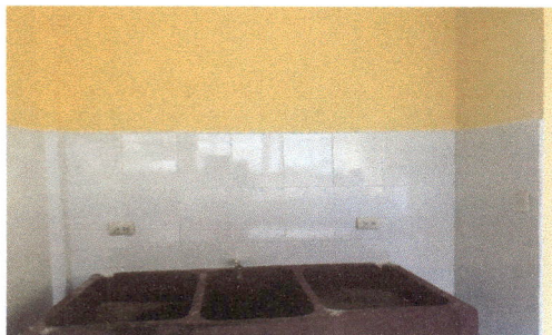
Foto 1: colocación de azulejo en el área de la pila una vez finalizada la reparación, en la imagen se observa el área de la pila con los azulejos dejando el área en condiciones adecuadas para su uso y mantenimiento
