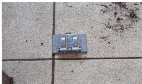
Foto 5: en la imagen se observan los tomacorrientes de piso ya reemplazados y correctamente instalados. Los nuevos dispositivos presentan una fijación adecuada y funcionamiento correcto
