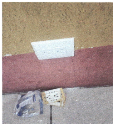
Foto 3: cambio de tomacorrientes una vez finalizada la reparación, en la imagen se observan los tomacorrientes ya reemplazados y correctamente instalados, evidenciando su correcto funcionamiento.
