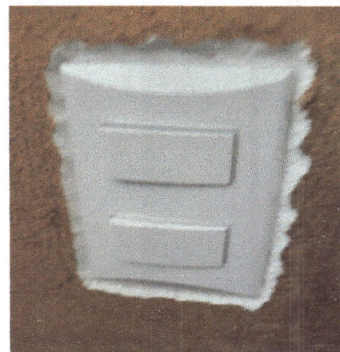
Foto 8: en la imagen se observan los interruptores nuevos correctamente instalados y fijados en su lugar, evidenciando que el trabajo fue concluido satisfactoriamente y que las instalaciones eléctricas están en buenas condiciones
