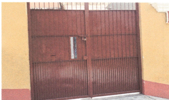
Foto 15: la reparación del portón tras finalizar la reparación, en la imagen se muestra el proton reparado evidenciando un trabajo concluido de manera satisfactoria y dejando el portón en buenas condiciones
