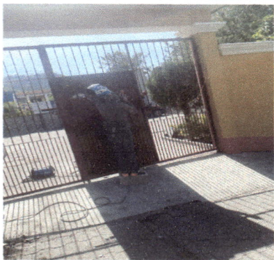
Foto 1: se están realizando trabajos de reparación en el portón del parqueo del establecimiento, con el fin de garantizar su correcto funcionamiento y la seguridad de los estudiantes
