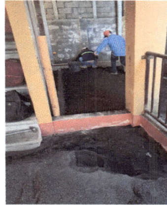
Foto 8: en la imagen se aprecia el proceso de elaboración de la bodega colocando el contrapiso
