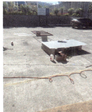
Foto 2: materiales a utilizar en la reparación de los portones
