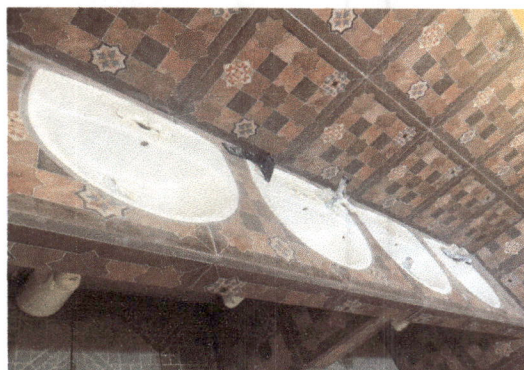
Foto 4: se lleva a cabo el proceso de cambio de los accesorios del lavamanos, reemplazando las piezas deterioradas para mejorar el uso y la higiene
