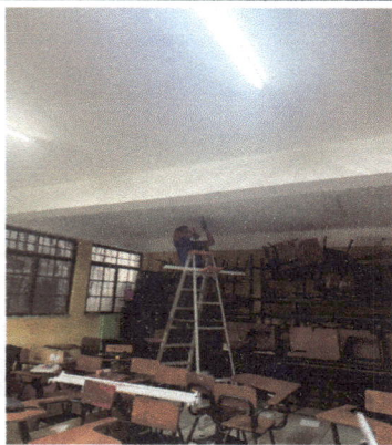
Foto 13: durante la actividad se llevaron a cabo trabajos de reemplazo de lámparas, garantizando iluminación adecuada y seguridad eléctrica
