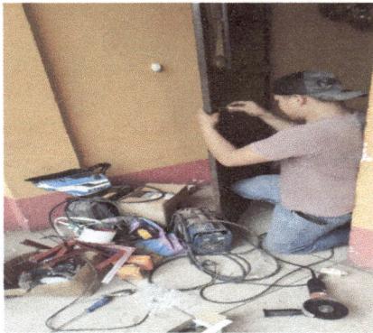
Foto 9: en la actividad se llevaron a cabo trabajos de reparación en las chapas de las puertas
