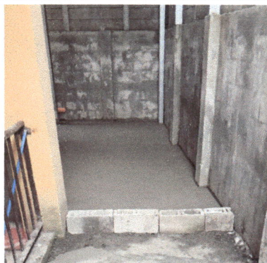
Foto 5: se realiza la colocación de contrapiso en la bodega, con el fin de mejorar las condiciones del espacio.
