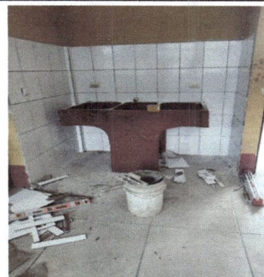
Foto 14: durante la actividad se llevó a cabo la instalación de azulejos en el área de la pileta, asegurando un acabado uniforme y duradero
