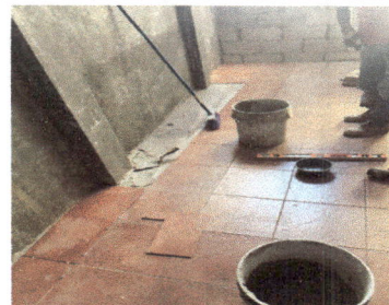
Foto 16: se realizó la colocación de azulejos en el área de la pileta, empleando cerámica resistente a la humedad y acabado liso
