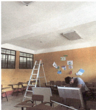
Foto 3: actualmente se lleva a cabo el reemplazo de las lámparas de los salones, como parte del remozamiento para mejorar la iluminación de los salones de clase
