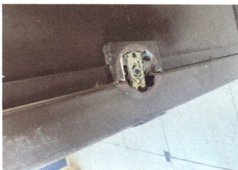
Foto 11: se ha detectado que las chapas presentan desgaste y daños, lo que dificulta su correcto funcionamiento y requiere reemplazo para garantizar la seguridad de las puertas
