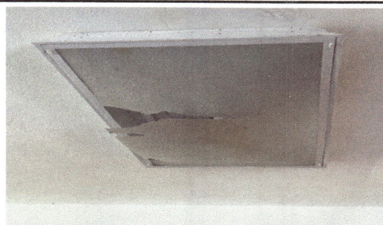
Foto 4: se ha detectado que las lámparas presentan deterioro y que algunas de ellas no están funcionando, por lo que requieren revisión y reparación
