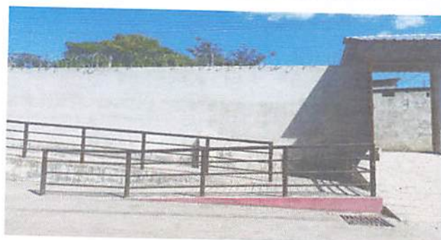
Vista actual del muro perimetral.
