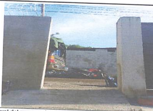
Vista actual del muro perimetral.
