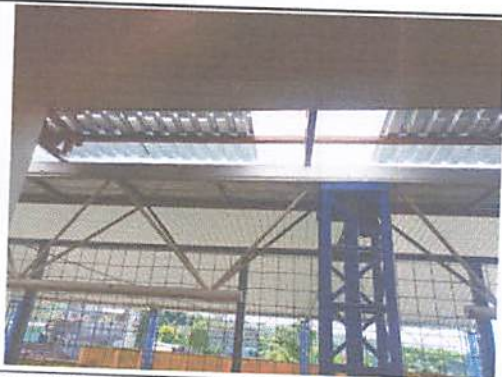
Vista de la caída de agua durante el remozamiento.
