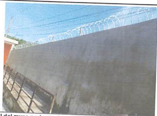
Vista actual del muro perimetral.
