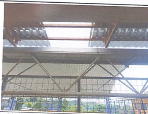
Vista de la caída de agua durante el remozamiento.
