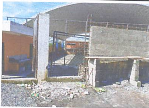
Vista actual del muro perimetral.
