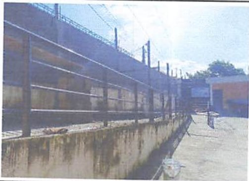
Vista actual del muro perimetral
