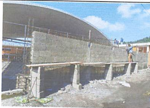
Vista actual del muro perimetral.
