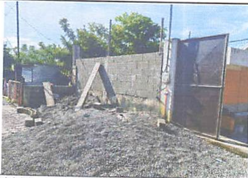
Vista actual del muro perimetral.
