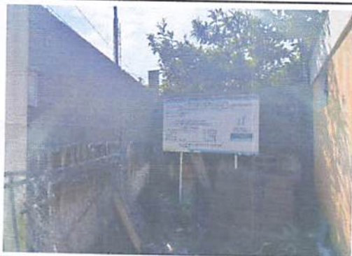
Vista actual del muro perimetral.
