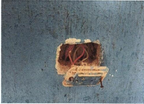
Instalación de tomacorrientes
