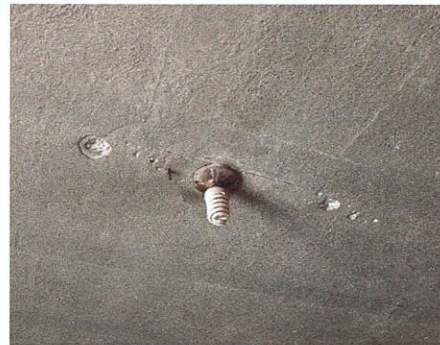
Instalación de iluminación en el techo
