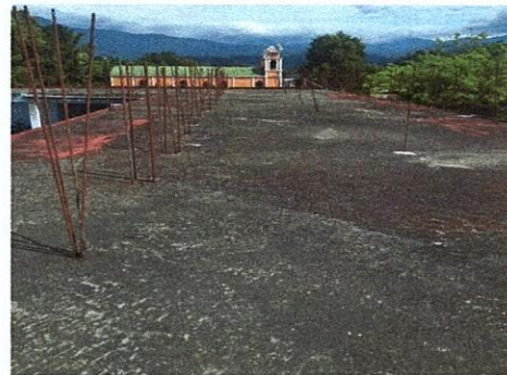
Vista lugar donde se trabajará la nivelación de bajadas de agua e impermeabilización
