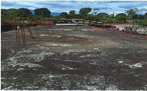
Vista del lugar donde se trabajara la nivelación de bajadas de agua e impermeabilización
