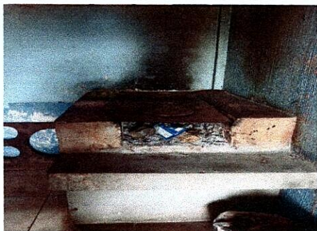
Lugar de implementación de polletón con azulejo y plancha
