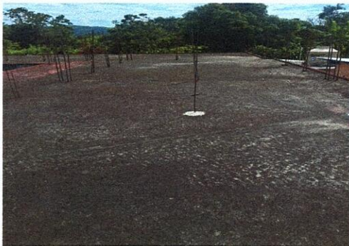
Vista del lugar donde se trabajara la nivelación de bajadas de agua e impermeabilización
