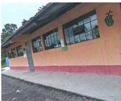
Foto 3: Pintura de salones
