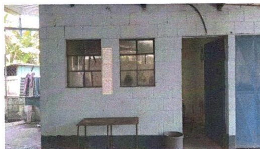
Foto 4: Ampliación de cocina
