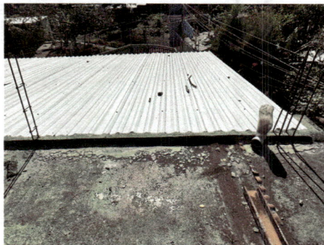
bajadas de agua concluido
