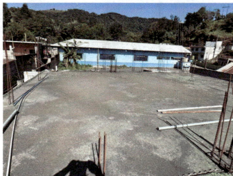
limpieza de las bajadas de agua
