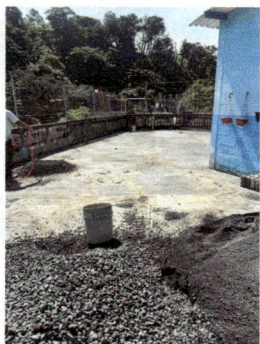
Foto 5 : fundición de pavimentación
