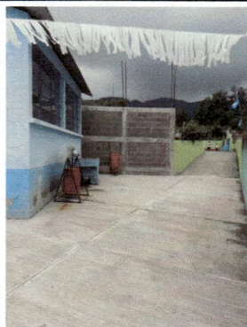
vista del techo de la Escuela Oficial de Párvulos
