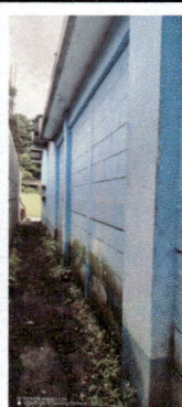
Vista actual de las bajadas de agua
