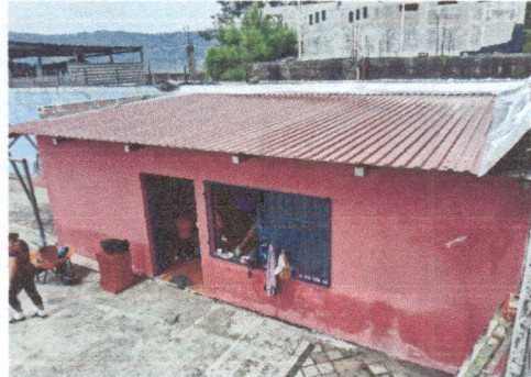
trabajos finalizados de cocina, lamina y ventanas
