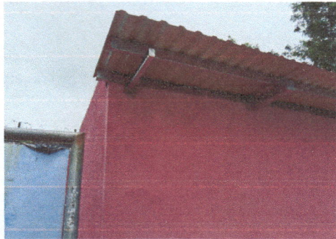
Trabajos finalizados de cocina
