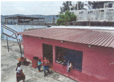
Vista actual de la situación de la cocina
