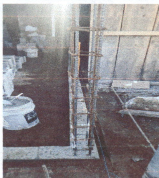
construccion de cicmiento de a cocina
