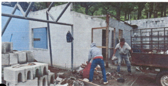
Trabajos de implemenacion de cocina
