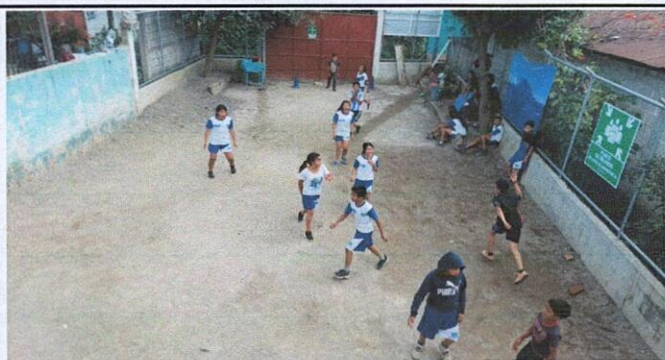
Foto 3: pavimento en mal estado
