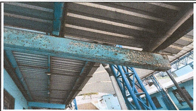
Foto 2: Mantenimiento de estructura metalica 13 costaneras de 25 mts. Lineales
