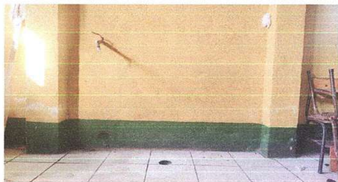
Foto 1: construcción de una pila en la cocina
