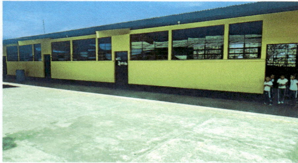
Foto1: Pintura aplicada en su totalidad
