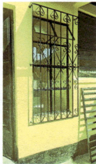
Foto 5: Ventanal y balcón terminados e instalados
