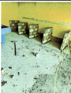
Foto1: Se inicia la elaboración de los top de cocina
