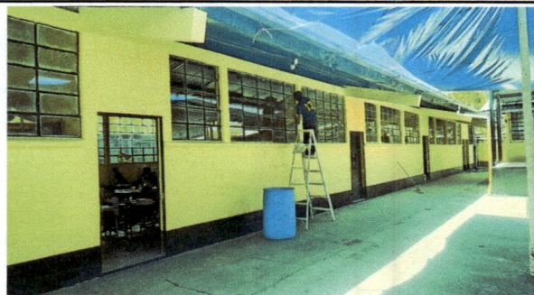
Foto 6: Aplicación de pintura en exteriores
