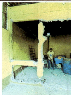
Foto 4: demolición de muro en cocina
