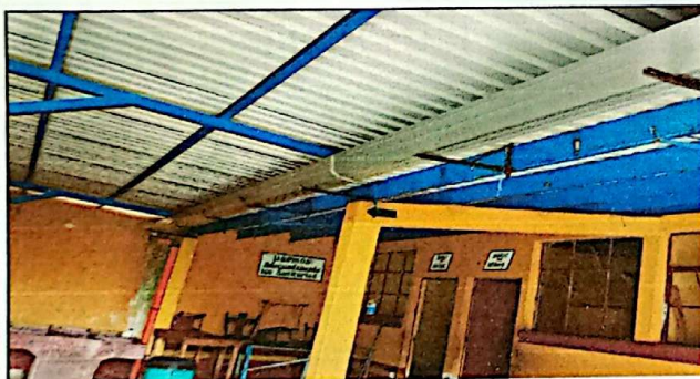
Colocación de Canales en los corredores de los 3 módulos
