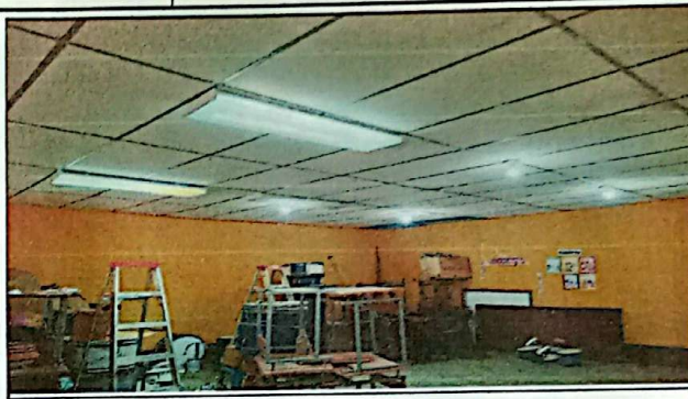
Cambio de Red eléctrica
