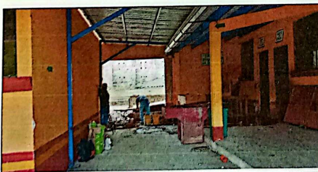
Ampliación y reparación de obra gris para portón metálico
