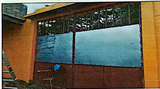
Reforzamiento de portones e Instalación de intercomunicador en el portón pequeño
