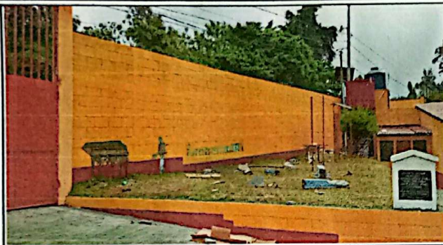
Pintura interior Muro Perimetral del frente del edificio
