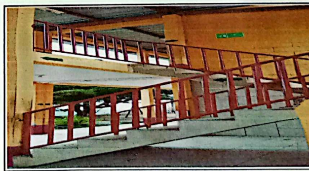
Desmontaje e instalación de baranda del segundo nivel de la parte de atrás
