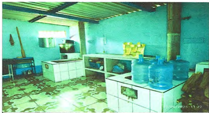
Foto 6: Colocación de puertas de metal en top de cocina, estanterias de metal y cambio de planchas de grueso calibre.
