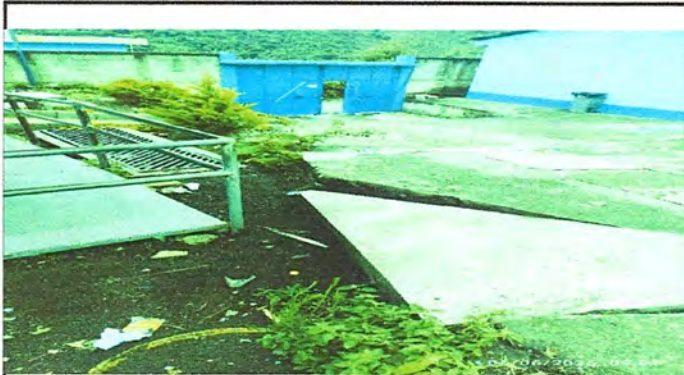
Foto 3: Reconstrucción de muro de contención.
