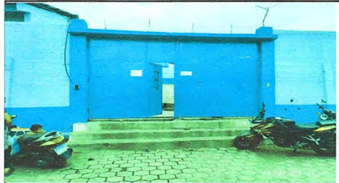
Foto 2: Remozamiento de Porton de Ingreso y convertirlo a portón corredizo, Cambio de puerta pequeña por descaste y chapa electrica.
